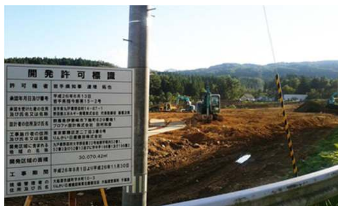
着工直後、野田バイオパワー建設現場
